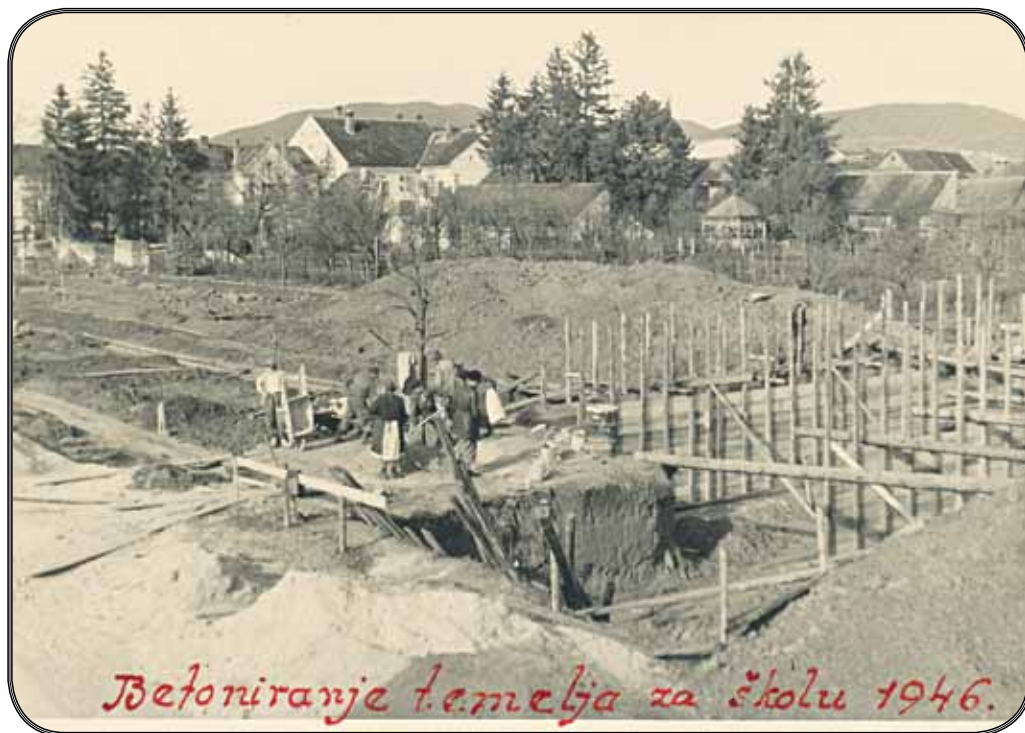
Nakon raščišćavanja ostataka stare, pristupilo se izgradnji nove školske zgrade
