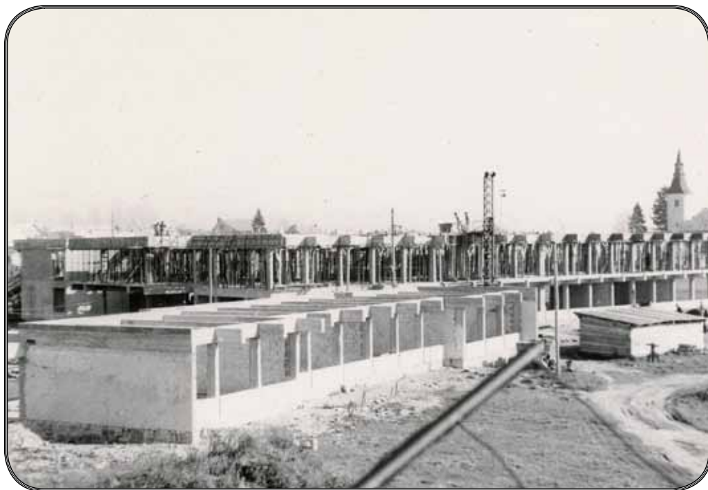
Radovi na izgradnji nove škole su trajali gotovo tri godine - slika 1
