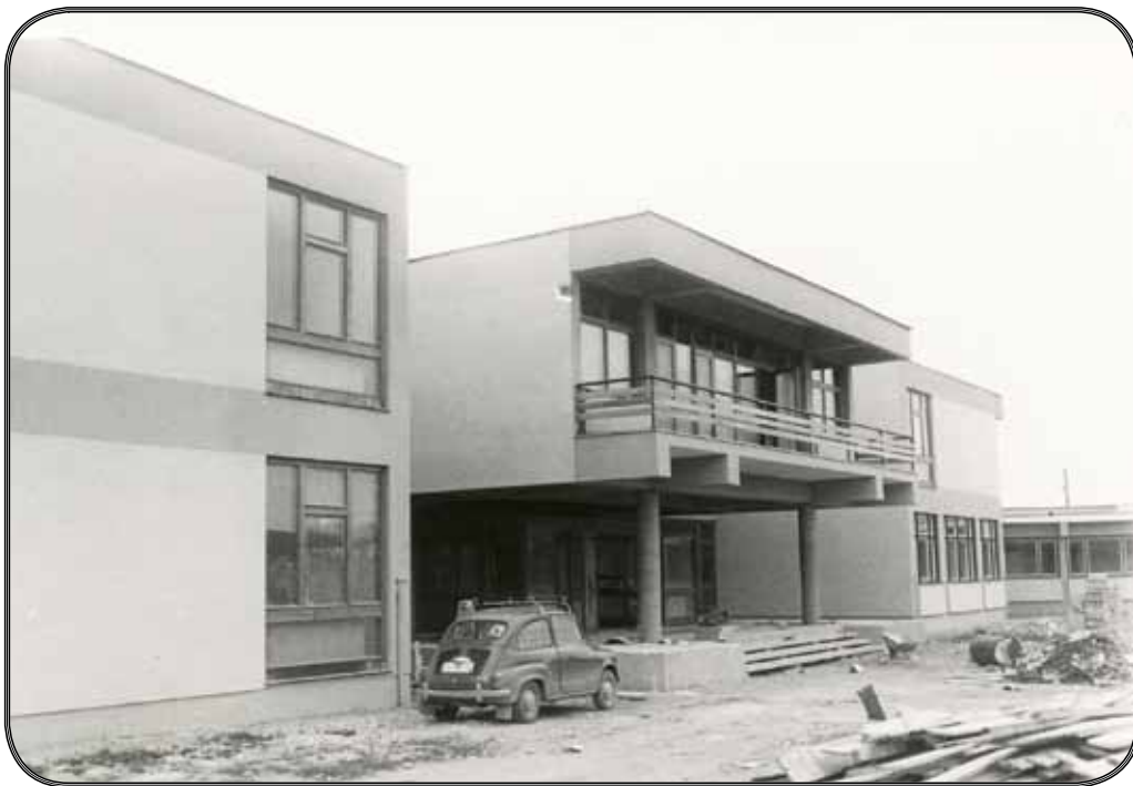
Radovi na izgradnji nove škole su trajali gotovo tri godine - slika 2
