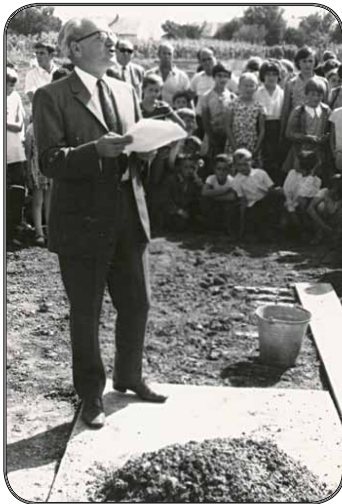
Ravnatelj škole Dragutin Effinger održava govor tijekom polaganja kamena temeljca nove školske zgrade u današnjoj ulici Ante i Davida Starčevića
